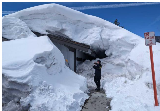
Figura 6: El personal de respuesta realiza una inspección estructural y del edificio.
