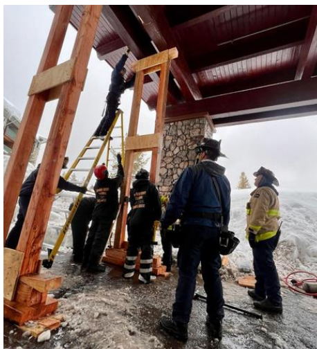
Figura 1: El equipo de Búsqueda y Rescate Urbano (Urban Search and Rescue, USAR) agrega apoyo estructural a un edificio.
